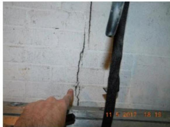
Colmater la fissure au mur de blocs mitoyen du garage.
