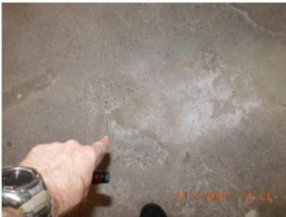
Colmater immédiatement les fissures à la dalle de béton du plancher de garage, pour empêcher l'infiltration d'eau pouvant affecter sa solidité et afin de conserver son intégrité structurale.
