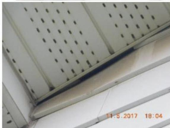
**Limitation:** L'inspecteur examine les soffites aux avant-toits à partir du sol pour vérifier s'il n'y a pas d'espacement ou de déplacement qui pourraient laisser la voie libre aux insectes, oiseaux ou rongeurs. À moins de déceler un indice d'une quelconque malfaçon ou d'un défaut important sur la partie supérieure des murs extérieurs, l'inspecteur ne scrutera pas les surfaces élevées à l'aide d'une échelle.
