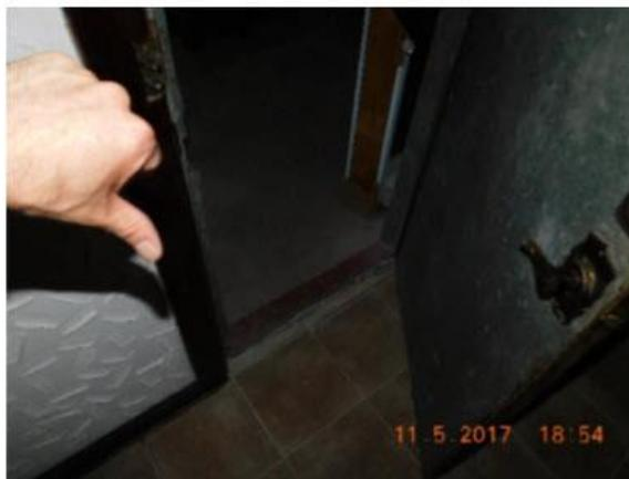
**IMPORTANT** la porte de service intérieure entre les aires habitables et le garage doit être certifiée coupe feu et munie d'un mécanisme refermant la porte automatiquement pour la sécurité des occupants. Corrigez immédiatement.
