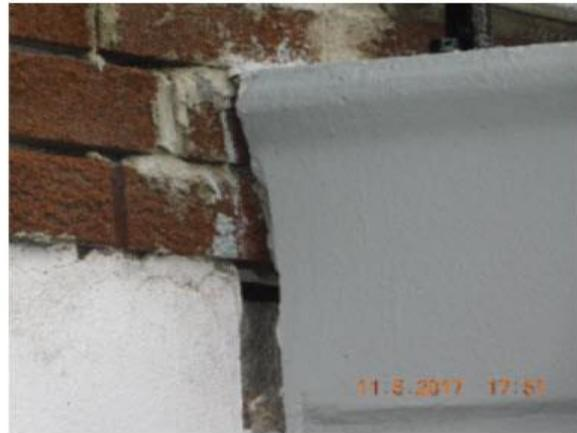
Nous avons observé une séparation entre le mur de la maison et le balcon. Prévoir un budget de correction et/ou réfection. Obtenir d'un spécialiste dans le domaine un estimé du cout de réfection avant la signature des contrats de vente.
