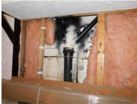
Selon la vendeur une infiltration ou fuite d'eau aurait causé des dommages au sous sol. Ceux-ci ont été réparés, mais aucune vérification des composantes ne peut être fait lors de cette inspection visuelle. Peut laisser présager que l'infiltration aurait, ou a causé des dommages aux composantes sous celui-ci. Une vérification doit être fait avant la signature complète des contrats pour en connaitre l'état et les coûts reliés si il y a lieu.
